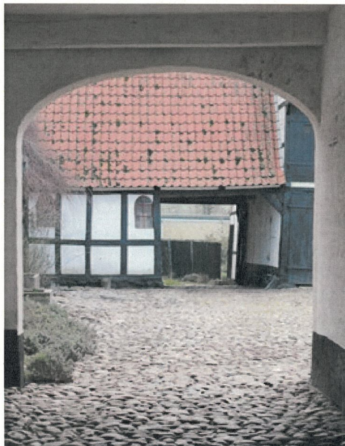
Åben port til det stenningsfulde pigstensbelagte baggårdsmiljø fra den tidligere købmandsgård på Søndergade 18. Baghuset fra 1770 er fredet. Baggårdsmiljøet vidner om byens blomstrende søfartsperiode i 1700-tallet.
